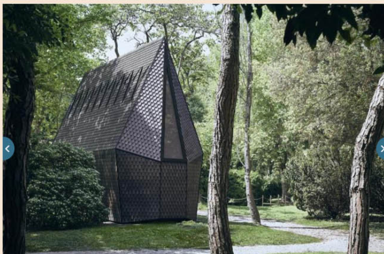
Il padiglione Asplund, degli architetti Francesco Magnani e Traudy Pelzel, è stato costruito dall'azienda Alpi della provincia di Forlì sul lessico delle tradizionali costruzioni in legno scandinave, le Stavkirken. All'esterno, sono montate 9mila scandole in legno mentre l'interno è totalmente rivestito in legno ALPI Xilo 2.0 Striped White, prodotto realizzato sotto la direzione artistica di Piero Lissoni.
