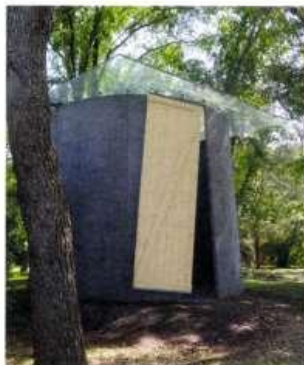
Viste della cappella pseudo costruzione spontanea cilena (animita) studiata da Smiljan Radic, con pareti sottili in cemento alleggerito (all'interno finito a bolle) di Moretti Prefabbricati e tetto vetrato di Saint-Gobain Italia
